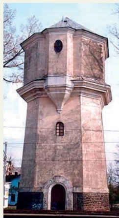
Wieża Ciśnień w Tłuszczu
